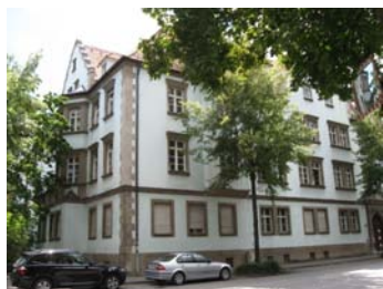
Das Gebäude des OEI in Regensburg
